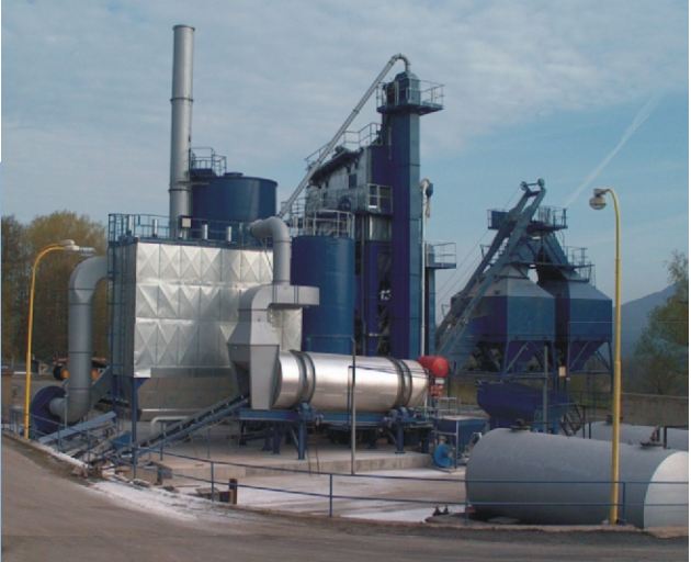
odprašení obalovny živčičných směsí filtrační výkon 45 000 m 3 /h
